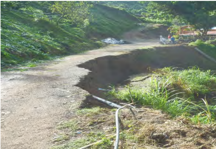
Camino Durante La Emergencia
