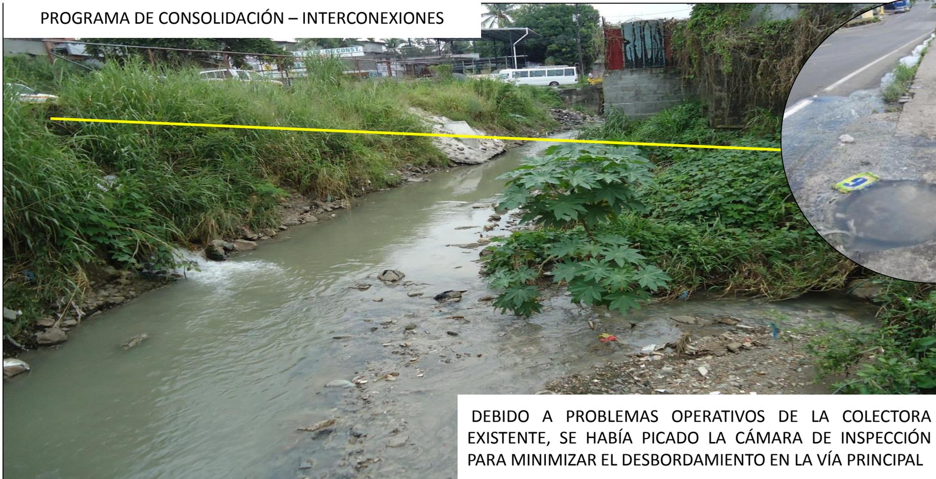
DEBIDO A PROBLEMAS OPERATIVOS DE LA COLECTORA EXISTENTE, SE HABÍA PICADO LA CÁMARA DE INSPECCIÓN PARA MINIMIZAR EL DESBORDAMIENTO EN LA VÍA PRINCIPAL
