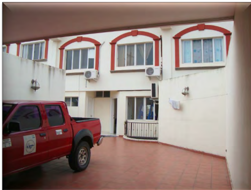
Entrada Principal Oficinas de la Dirección Ejecutiva Nacional del Plan Trifinio en Honduras Tegucigalpa, Honduras
