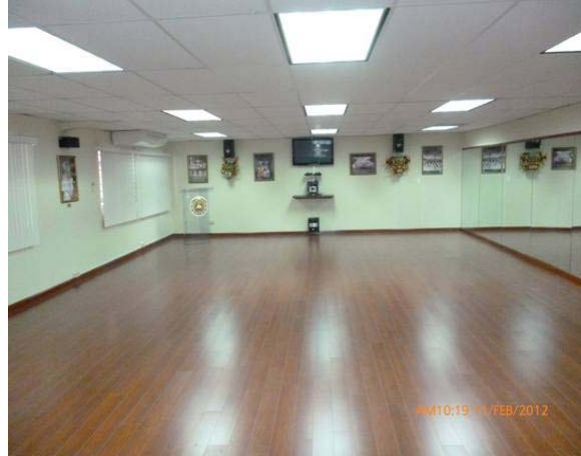
Programa de Remodelaciones del 1er. Trimestre de la vigencia 2012, remodelado y ampliado el área asignada al Conjunto Típico de la Contraloría.
