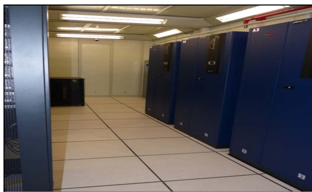
Sistema de Climatización de Precisión Centro de Datos Institucional (Sala Cofre) 04/12/2012
