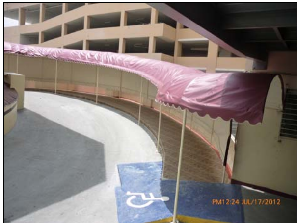
Suministro e instalación de tolda tipo túnel y baldosas antirresbalantes, en la rotonda hacia la Cafetería
